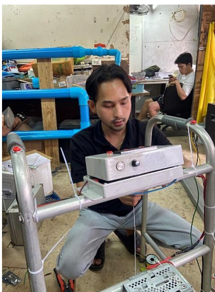
รูปภาพที่ 3.6 ติดตั้งท่อและติดกล่องอุปกรณ์
